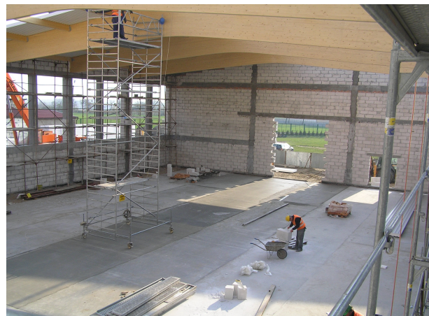
Hala widowiskowo-sportowa w trakcie budowy
